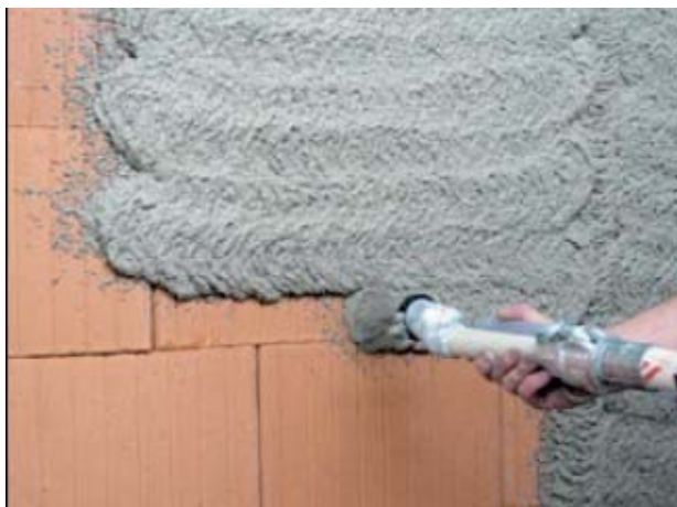
Bild 14: Auftrag des Unterputzes auf Planziegelmauerwerk
