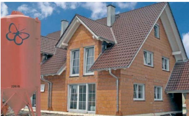
Bild 4: Homogener Putzgrund
