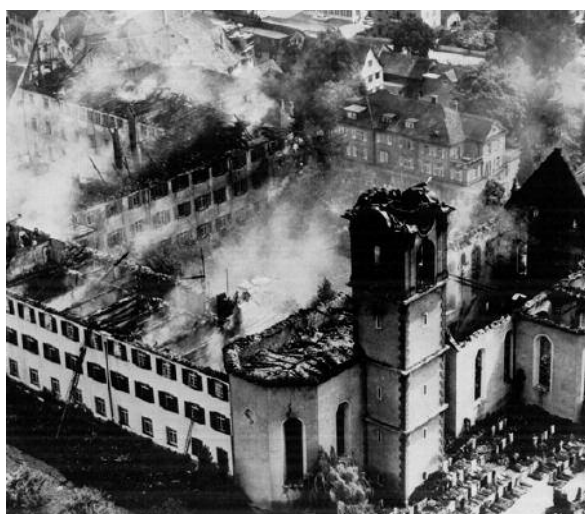
Bild 5: Brandweiterleitung aufgrund fehlender Brandwände
