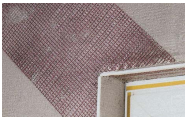
Bild 7: Armierungspfeil an Öffnungsecken
