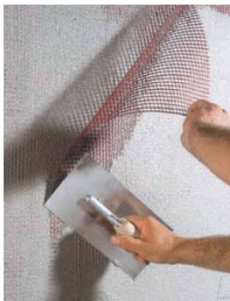
Bild 8: Armierungsputz mit Gewebeeinlage
