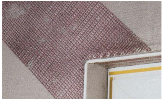
Bild 7: Armierungspfeil an Öffnungsecken
