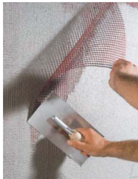
Bild 8: Armierungsputz mit Gewebeeinlage
