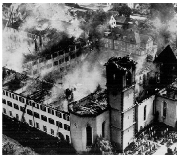
Bild 5: Brandweiterleitung aufgrund fehlender Brandwände
