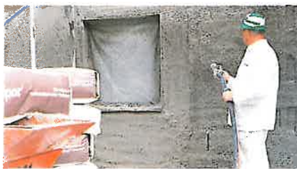
Putzlagen bis zu 6 cm Dicke werden in einem Arbeitsgang aufgespritzt, hier dargestellt an einer Altbau-sanierung
