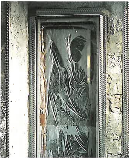
Zuerst die Eckschienen setzen.
